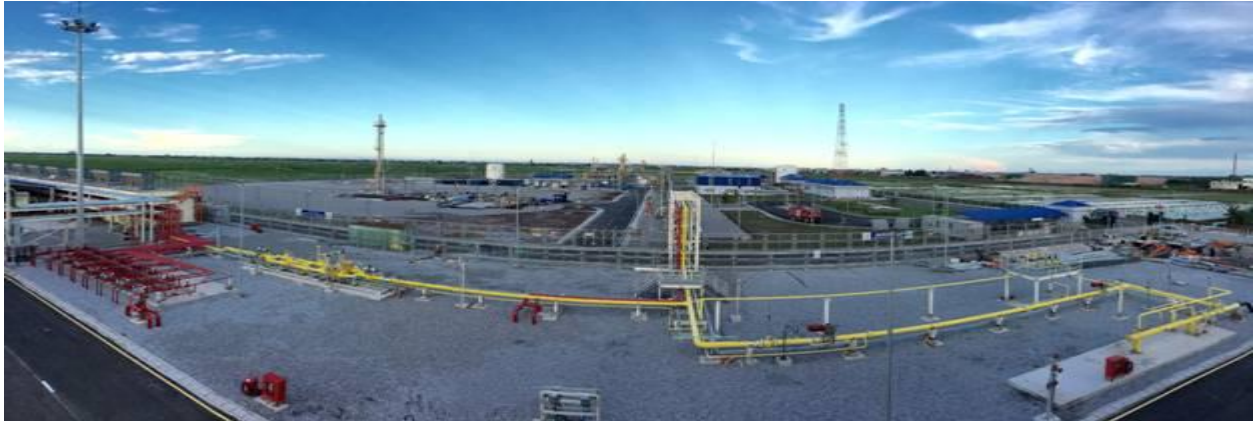
Dự án xây dựng công trình trên bờ
