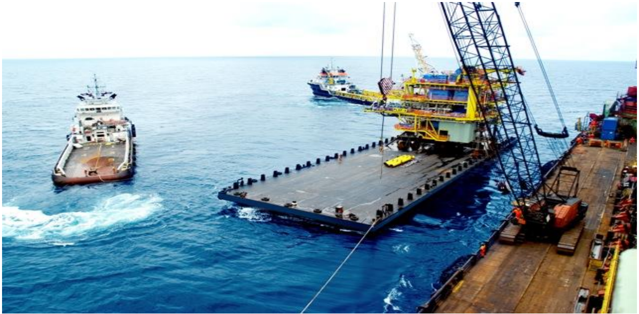
Dự án xây lắp công trình biển
